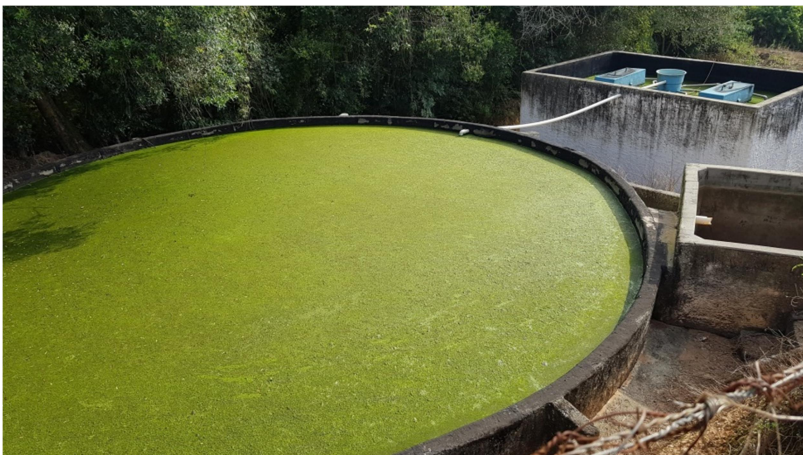
Tanque de decantação de rejeitos (Sangue)
